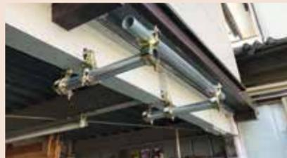
③取付ける土台には、これまた工事現場で使われる『単管パイプ』と呼ばれるもの。専用のアタッチメントを購入して車庫のH鋼に取付けました。ペニヤ板の重量を支えるには十分すぎる耐性があります(笑)♪
