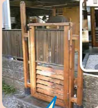
『家にもう一つ出入口が欲しいな〜』ってことでつくりました。外壁を一部破壊して下に鉄筋コンクリートの基礎を作り補強。門扉も切断したフェンスを再利用してみました。今では正規の出入口を使うのは来客時のみです…。
